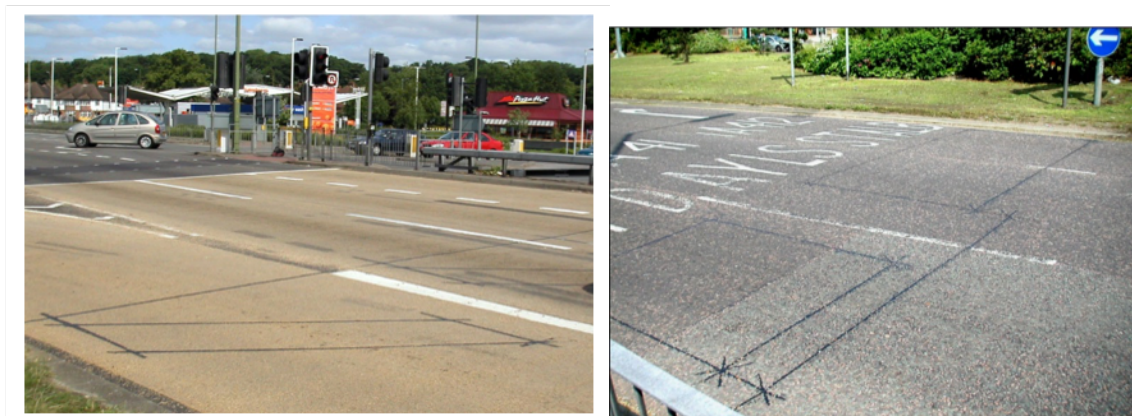
Figura 14 – Bucle inductive instalate în asfalt (exemplu)
