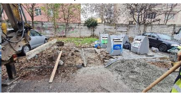
În timpul lucrărilor
