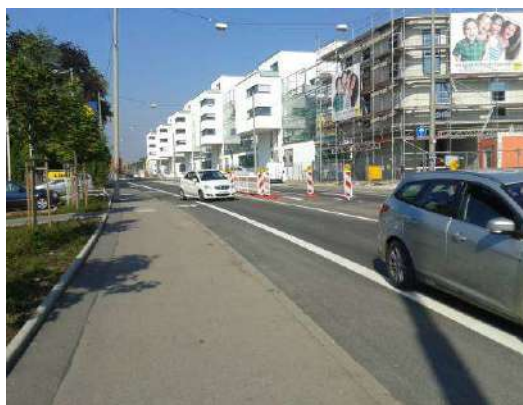
Figura 30: Trotuare amenajate corespunzător, Germania
