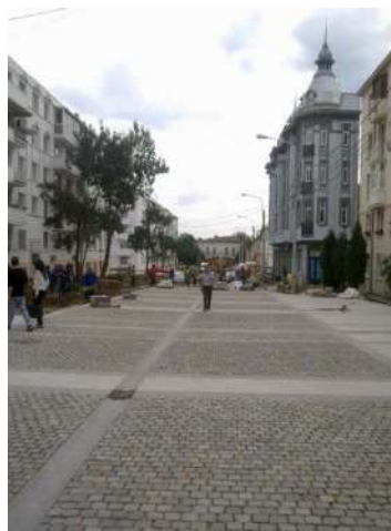
În timpul lucrărilor, septembrie 2014 (fotografie din arhiva proprie)
