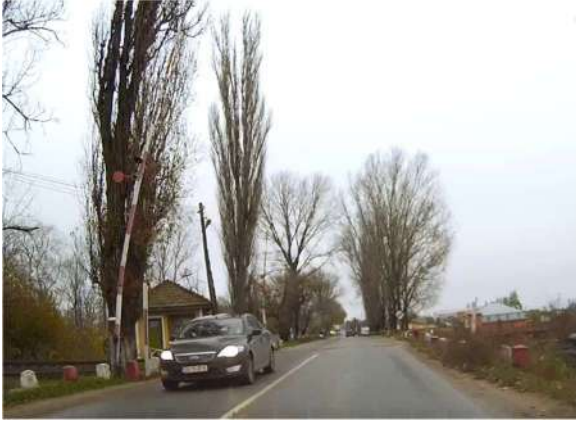
Figura 36: Exemplu de trecere la nivel cu calea ferată amenajată necorespunzător, Craiova, Strada Prelungirea Bechetului
