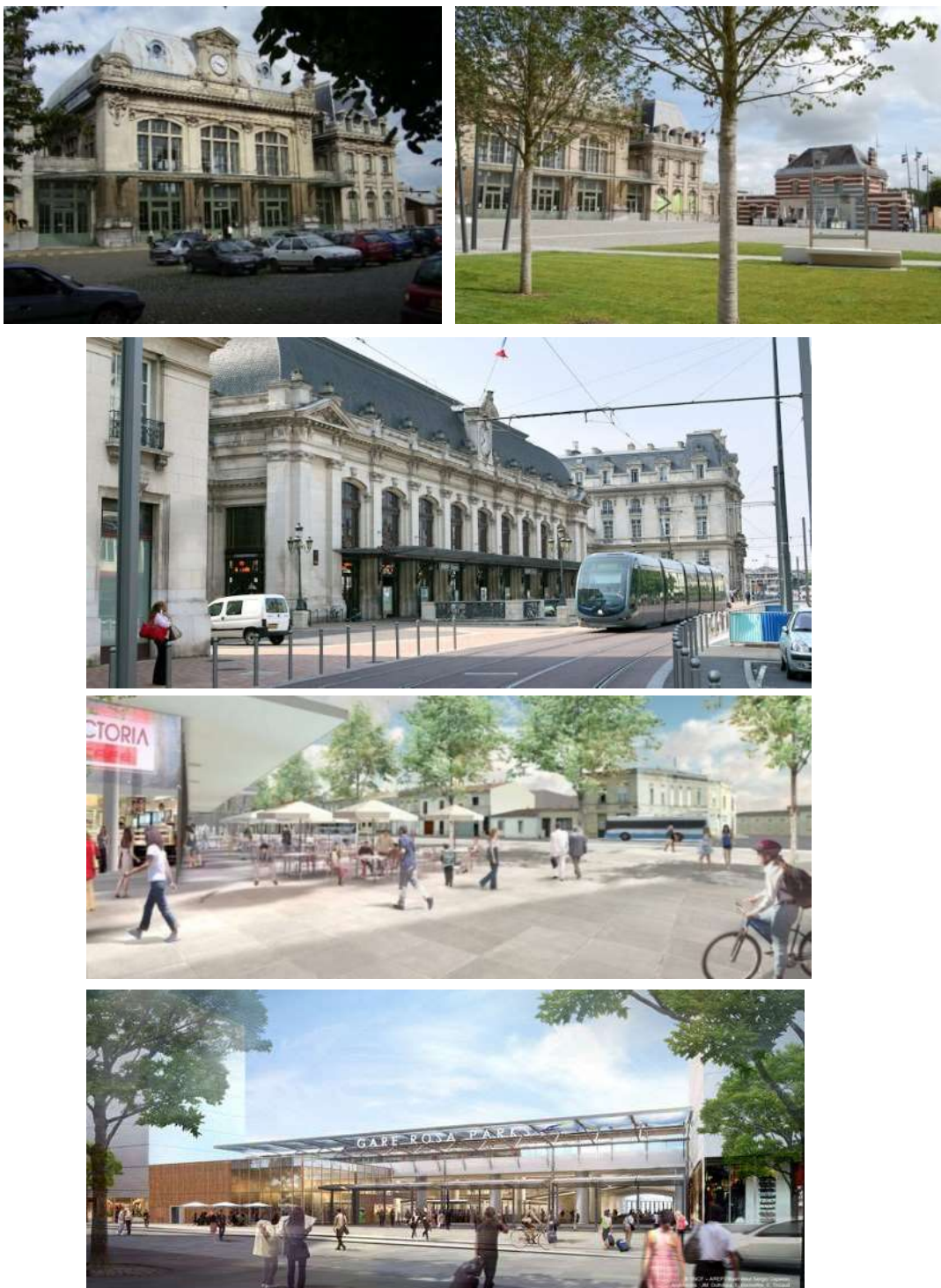
Figura 160: Exemplificări, bune-practici: reorganizări ale garilor ca poli intermodali și reamenajarea zonelor adiacente ca areale favorabile deplasărilor nemotorizate și transportului public: a. Reamenajare gară Saint-Omer (Pas-de-Calais), b. Reamenajarea gării Saint-Jean (Bordeaux), c. Gara Belcier (Bordeaux), d. noua Gara Rosa-park, pe linia RER E (Paris)
