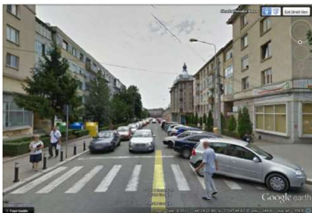
Înainte de începerea lucrărilor (Google Earth)
