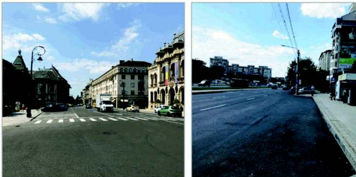
Figura 2.17. Starea tehnică a infrastructurii stradale – exemplificare.
