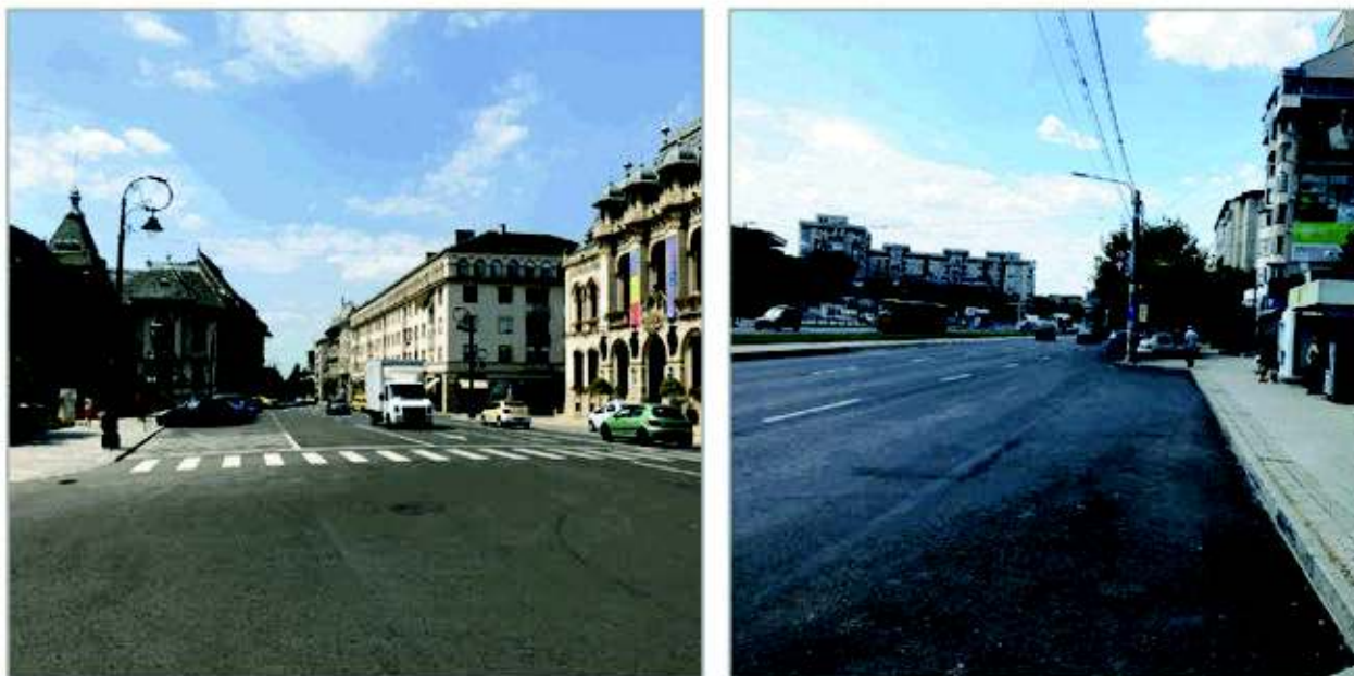
Figura 2.17. Starea tehnică a infrastructurii stradale – exemplificare.
