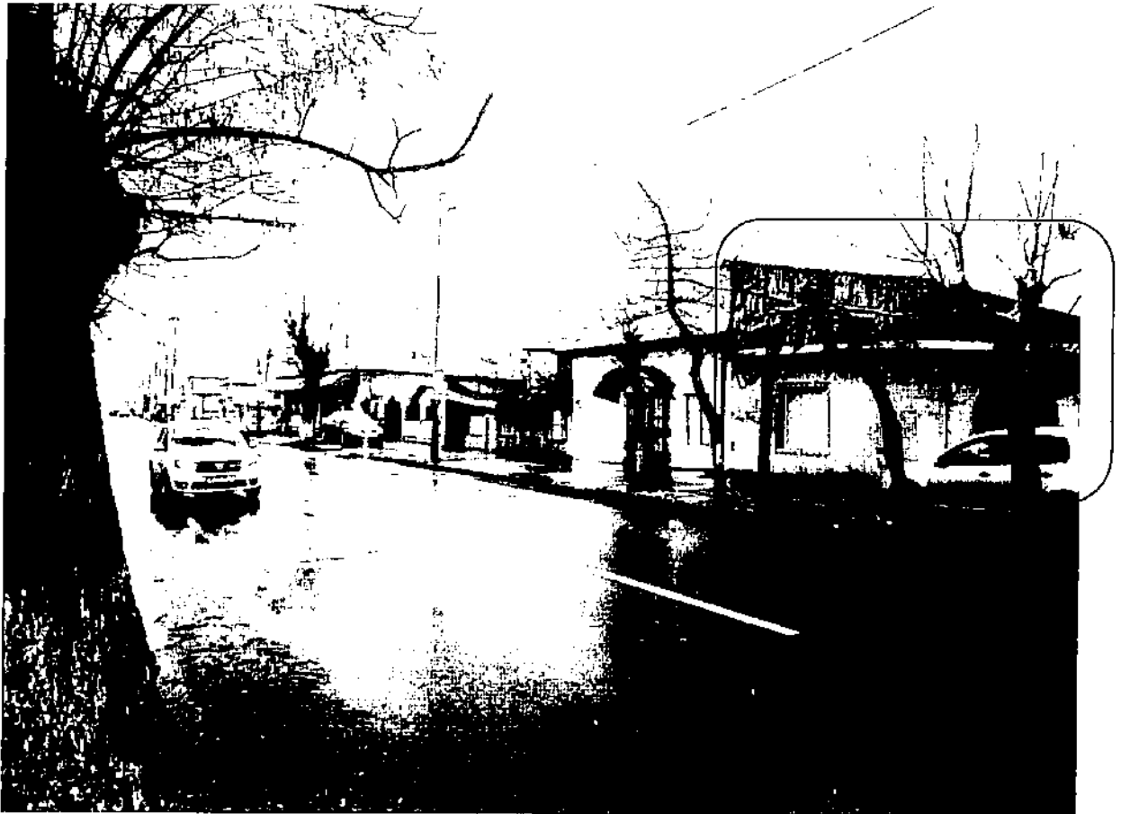
Vedere din str. Brestei
