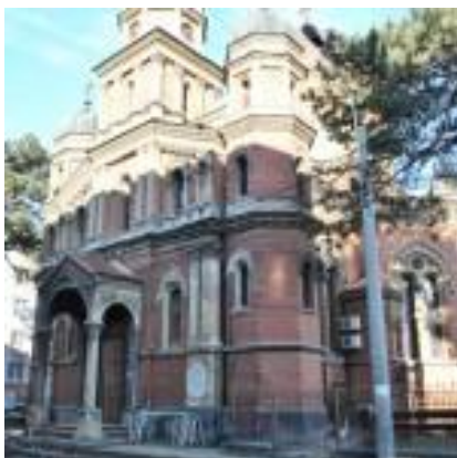
Biserica Sf Ilie, Craiova - In timpul lucrarilor de renovare a centrului orasului
