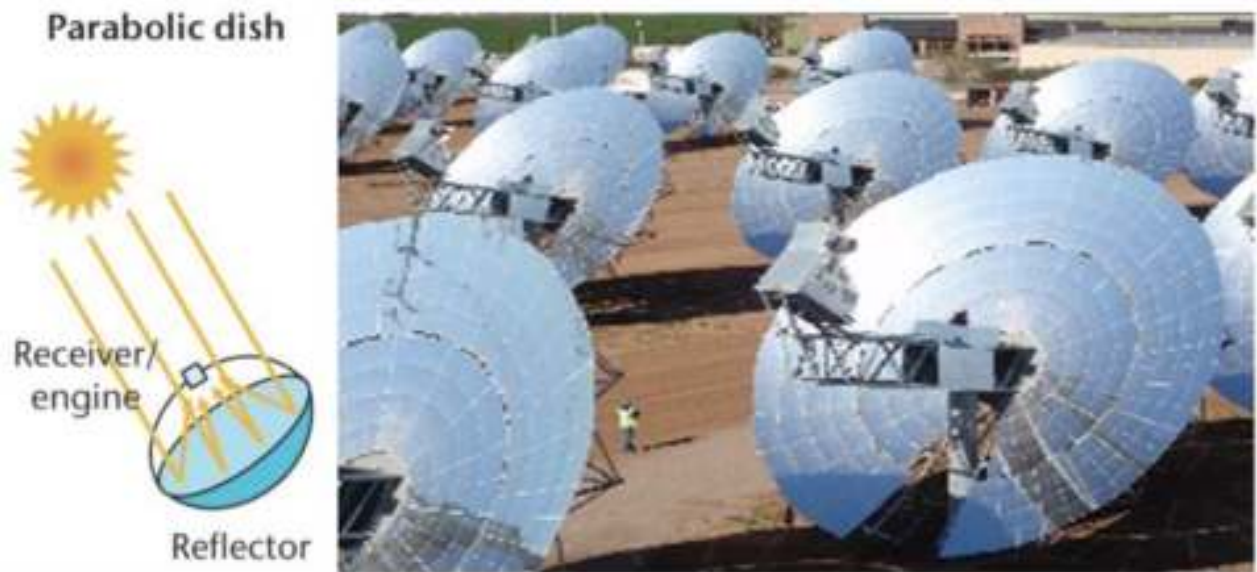
Figura – Sistem de oglinzi parabolice
