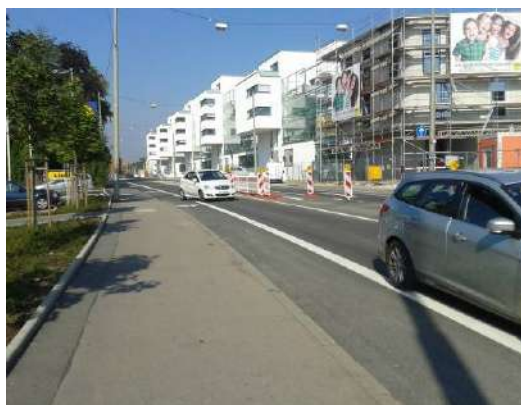
Figura 30: Trotuare amenajate corespunzător, Germania
