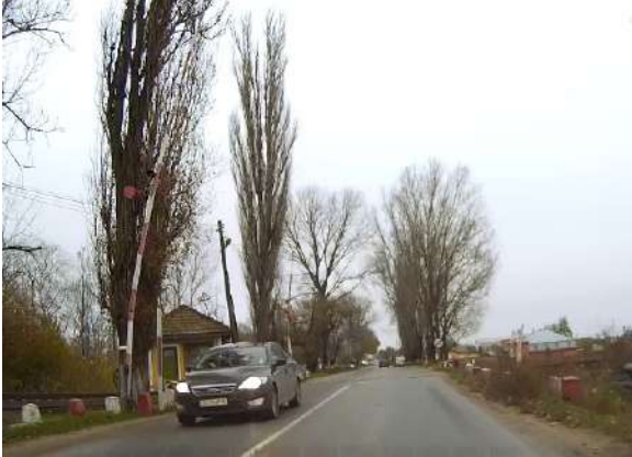
Figura 36: Exemplu de trecere la nivel cu calea ferată amenajată necorespunzător, Craiova, Strada Prelungirea Bechetului
