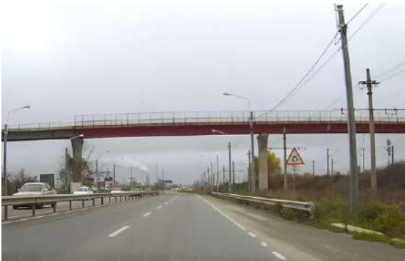
Figura 25: Dispozitiv de protecție periculos, Craiova, Calea Severinului
