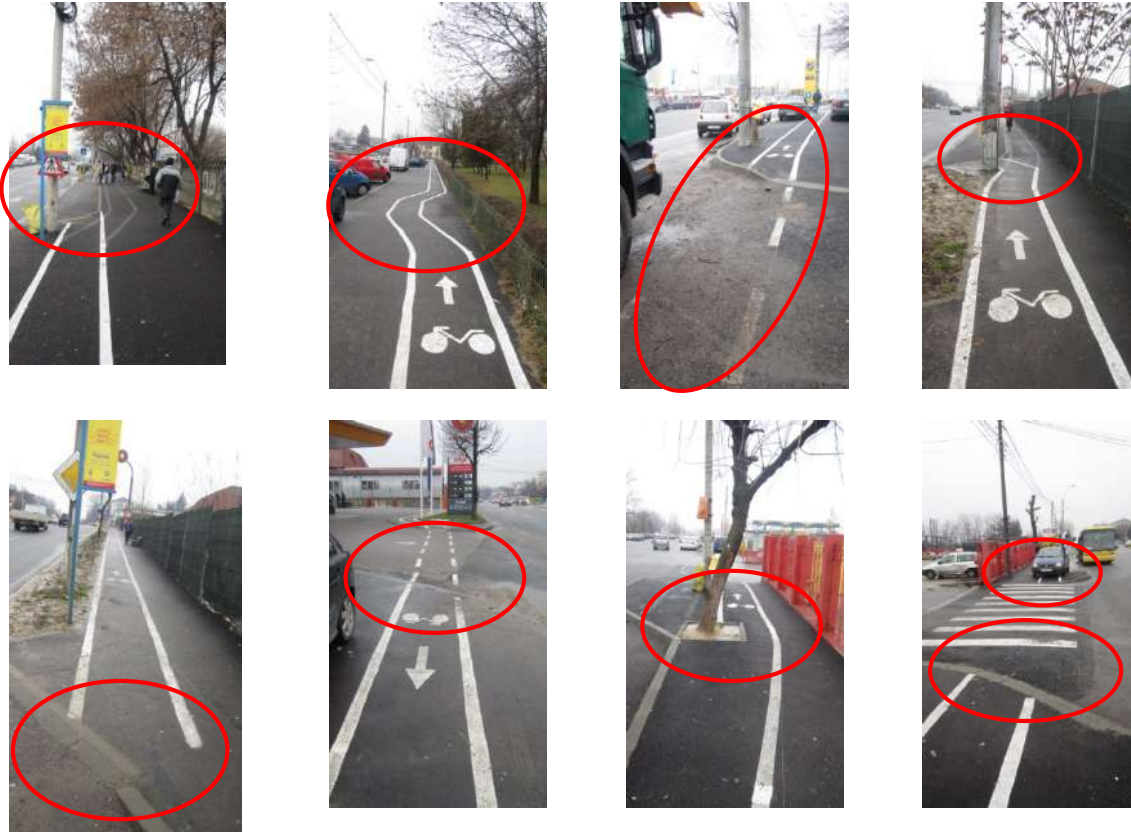
Figura 49: Exemple cu deficiențe majore semnalate pe traseele pistelor de biciclete de pe strada Caracal (fotografiile din arhiva proprie)
