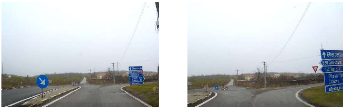
Figura 17: Exemplu de amplasarea necorespunzătoare a indicatoarelor rutiere în intersecție, Craiova, intersecția dintre Strada Teilor și Centură Nord
