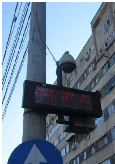
Figura 66: CCTV pentru supravegherea stațiilor de transport public. Server-ul din dispeceratul RAT (fotografie din arhiva proprie)
