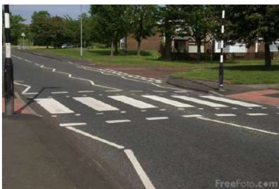
Figura 138: Exemple de amenajări ale trecerilor de pietoni accesibile pentru persoanele cu dizabilități
