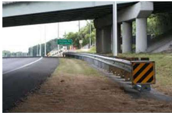
Figura 26: Dispozitive de protecție corespunzătoare (Sursă: Manual de siguranță rutieră pentru Rep. Moldova. Administrația de Stat a Drumurilor, 2011)
