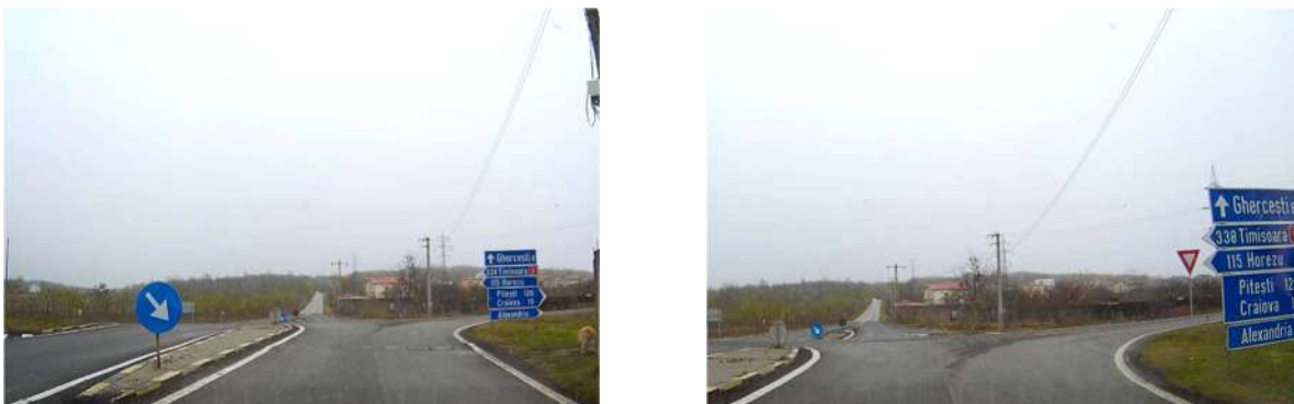
Figura 17: Exemplu de amplasarea necorespunzătoare a indicatoarelor rutiere în intersecție, Craiova, intersecția dintre Strada Teilor și Centură Nord
